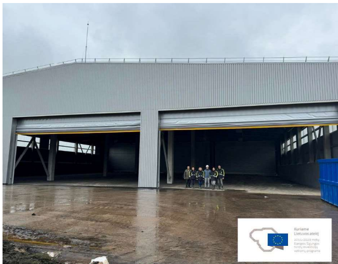
1 pav. MVA apdorojimo pastatas
