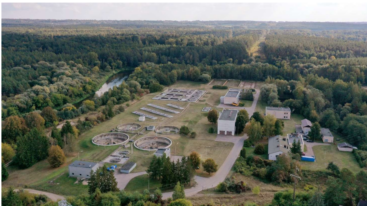
1.2.1 pav. UAB „Ukmergės vandenys“ nuotekų valymo įrenginiai
