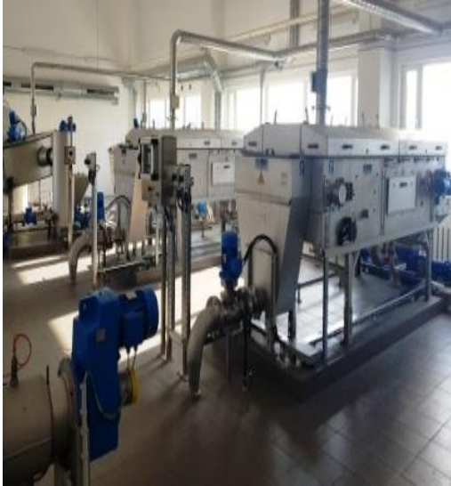
23 pav. Dumblo tankinimo įrenginių statyba
