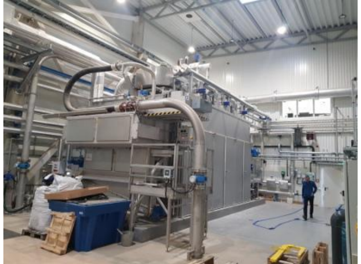
24 pav. Dumblo džiovinimo įrenginių statyba
