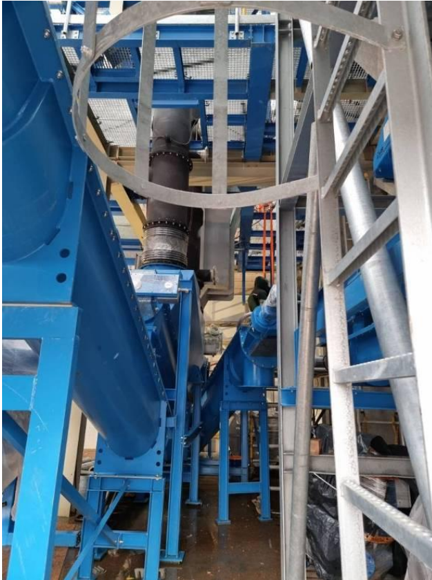
25 pav. Dumblo deginimo įrenginių statyba
