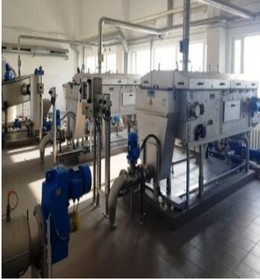
23 pav. Dumblo tankinimo įrenginių statyba
