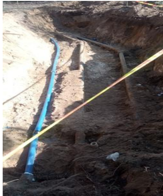
8 pav. Vandentiekio vamzdynų renovacijos darbai
