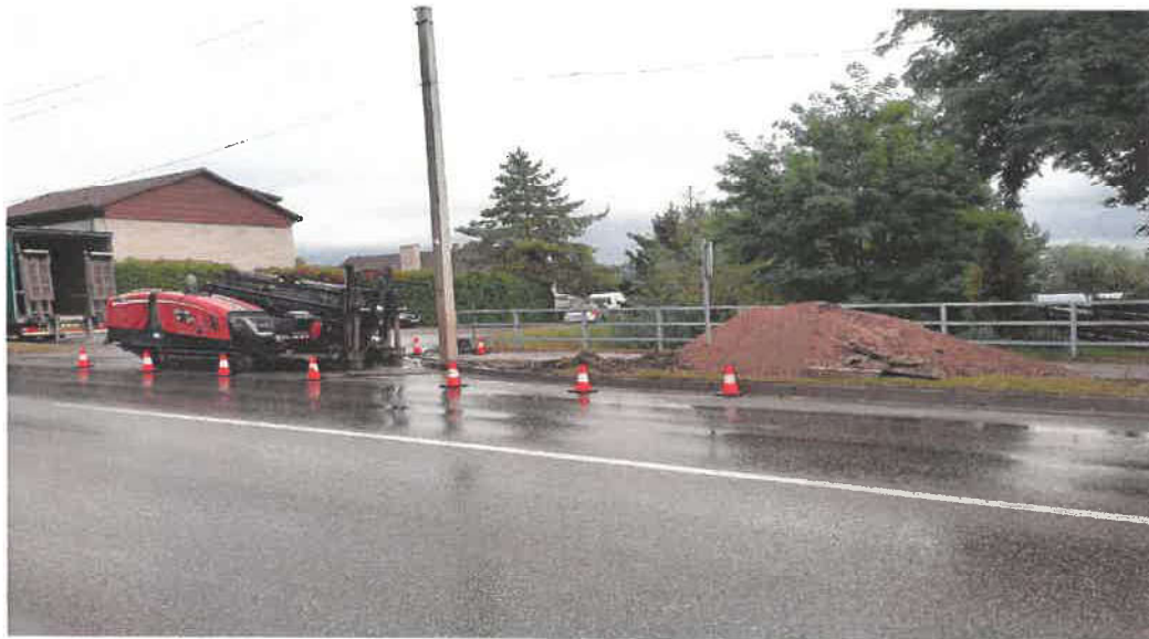
14 pav. vykdomi darbai Kauno gatvėje.
