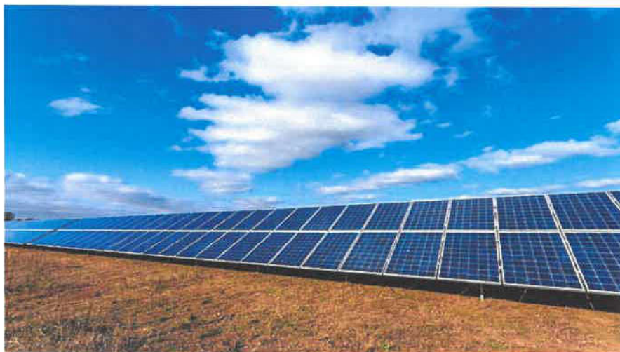
18 pav. Saulės elektrinių statyba
