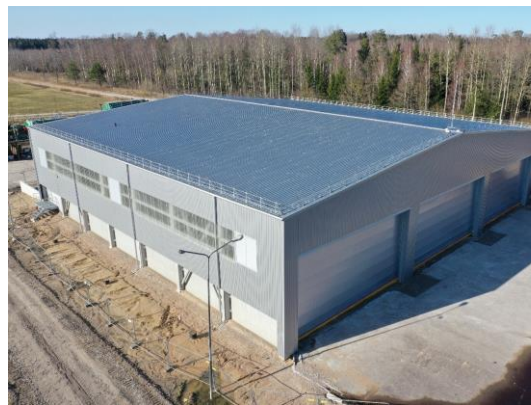
3 pav. MVA apdorojimo pastatas
