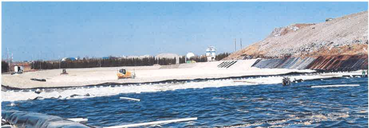
13 pav. Klaipėdos regioninio sąvartyno III sekcijos įrengimo darbai
