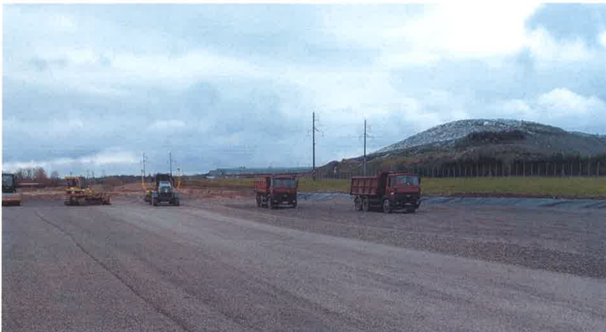
14 pav. Šlako apdorojimo aikštelės (II etapo) įrengimo darbai
