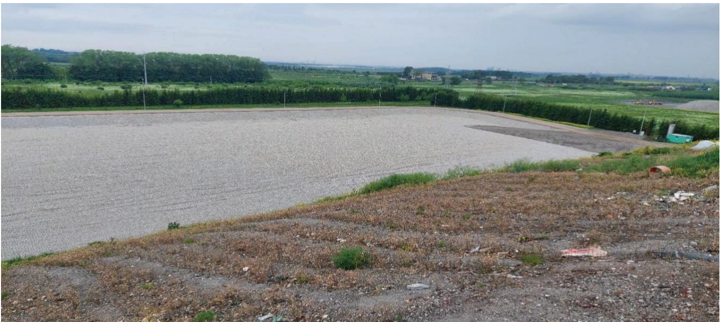
14 pav. Klaipėdos regioninio sąvartyno III sekcijos įrengimo darbai
