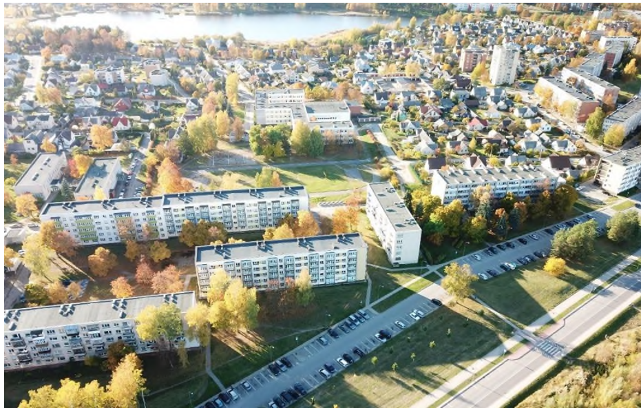
4 pav. Daugiabučio namo atnaujinimas (modernizavimas) Utenoje
