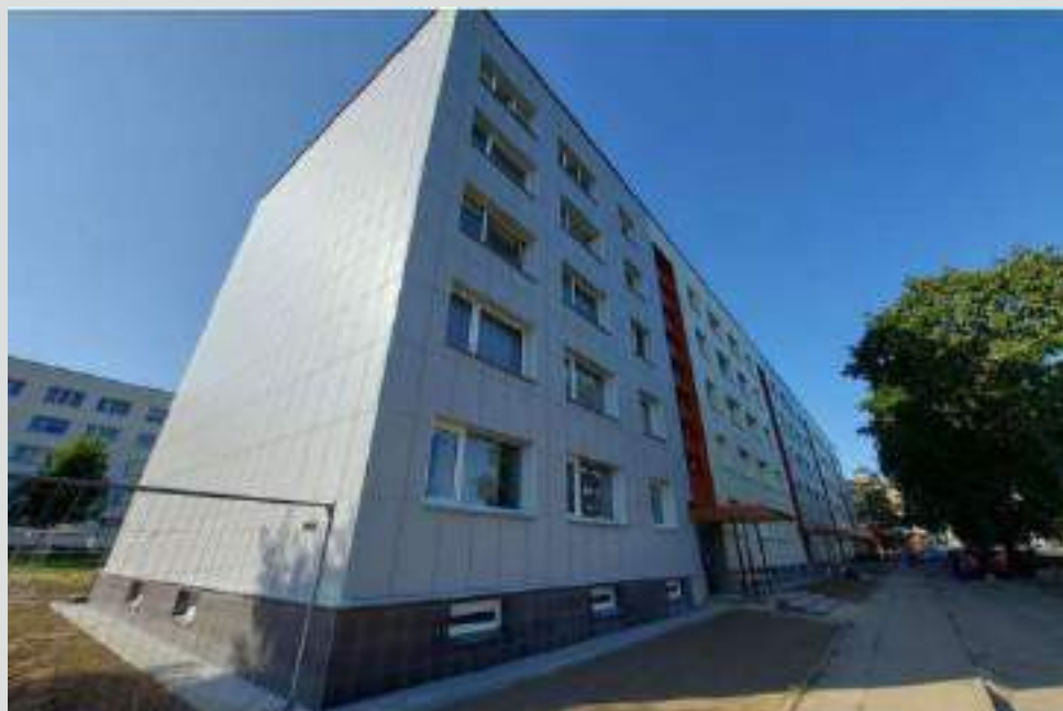
Atnaujintas (modernizuotas) daugiabutis namas, esantis adresu Taikos g. 4A, Utena
