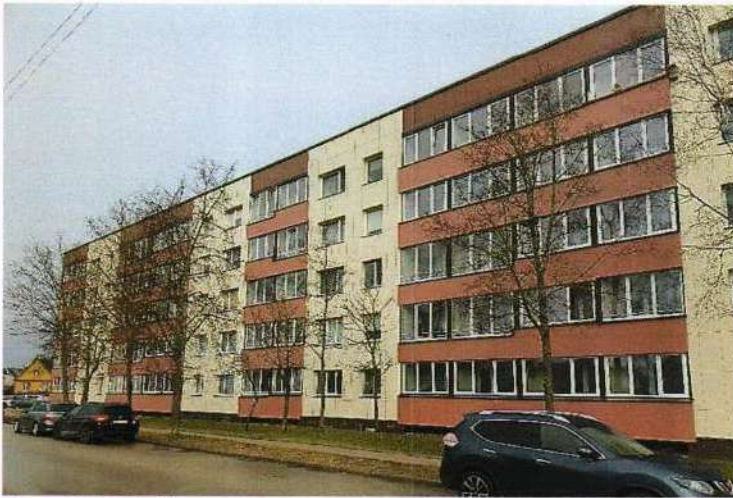
6 pav. Daugiabučio namo, adresu Sėlių g. 59, Utena, atnaujinimas (modernizavimas).
