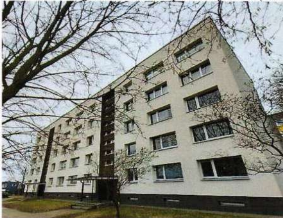
10 pav. Daugiabučio namo, adresu Taikos g. 4, Utena, atnaujinimas (modernizavimas).
