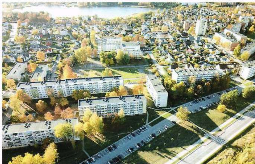
3 pav. Daugiabučio namo atnaujinimas (modernizavimas) Utenoje
