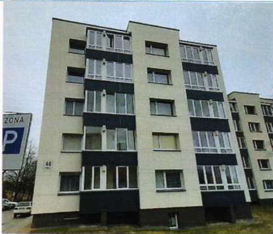
12 pav. Daugiabučio namo, adresu Taikos g. 46, Utena, atnaujinimas (modernizavimas).
