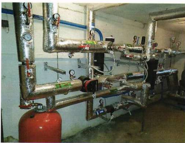
14 pav. Daugiabučio namo, adresu Užpalių g. 82, Utena, šildymo ir karšto vandens sistemų atnaujinimas (modernizavimas).
