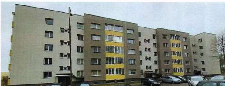
8 pav. Daugiabučio namo, adresu Taikos g. 96, Utena, atnaujinimas (modernizavimas).
