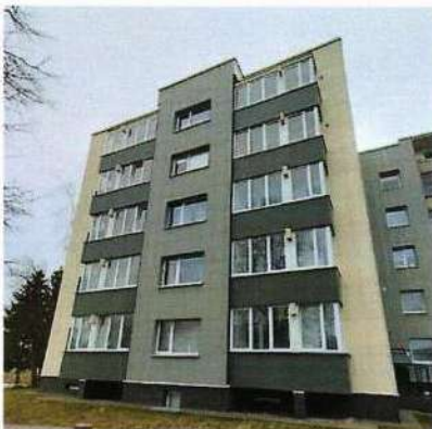
11 pav. Daugiabučio namo, adresu Taikos g. 90, Utena, atnaujinimas (modernizavimas).
