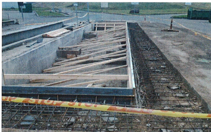
28 pav. Automobilinių svarstyklių pamatų remonto darbai
