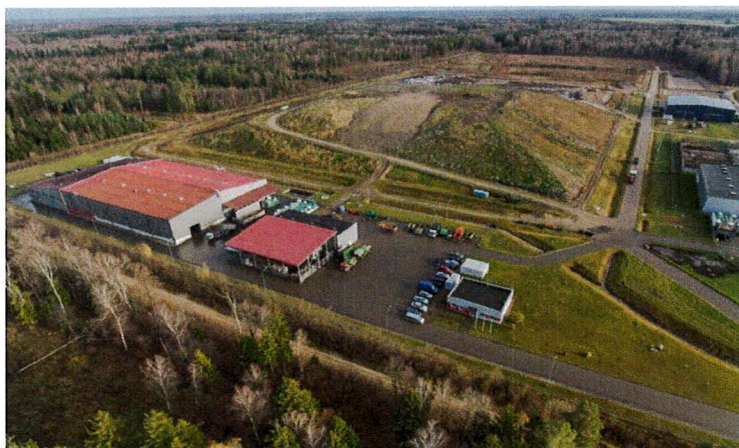
19 pav. Panevėžio regioninis sąvartynas
