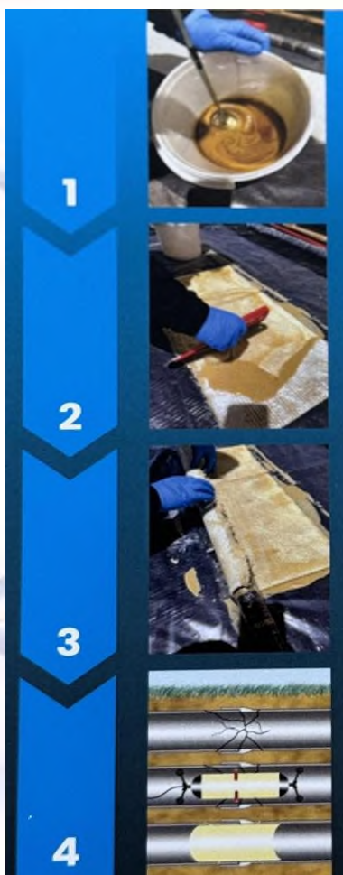
Mažeikių m. Algirdo g. nuotekų tinklui DN400 mm atlikti rekonstrukcijos darbai penkiose vietose taikant betranšėjinį remontą CIPP, kuriuos atliko UAB „Sewage Solutions“.
