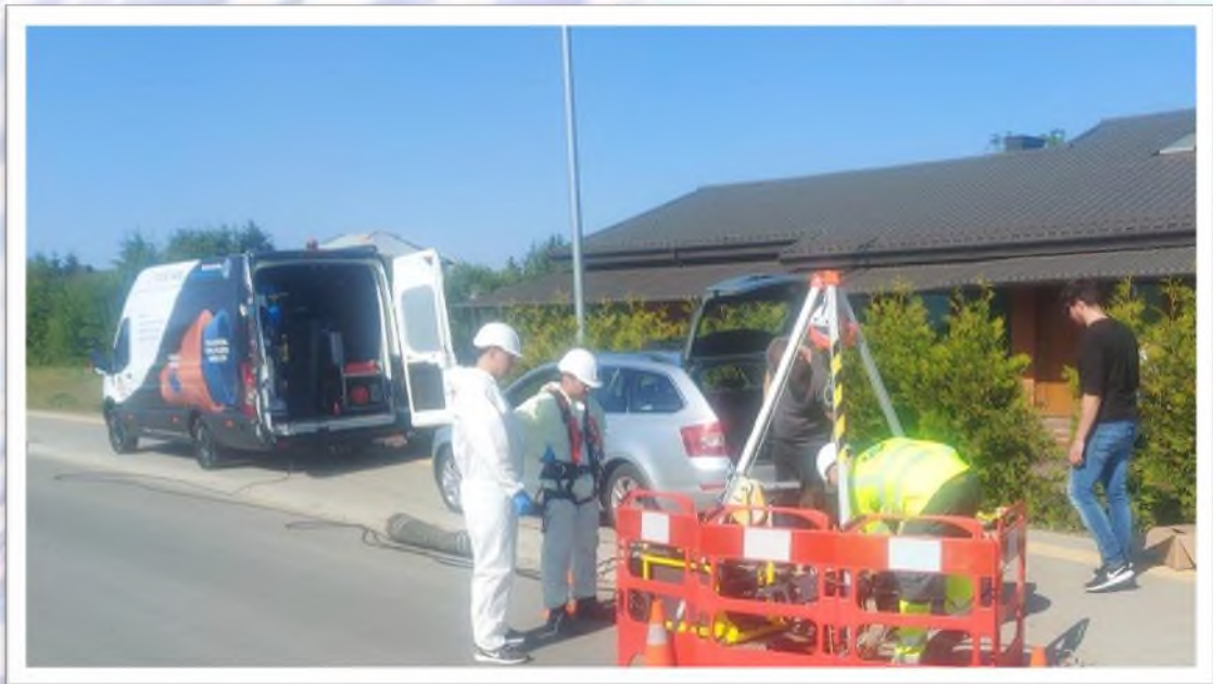
Mažeikių m. Algirdo g. nuotekų tinklui DN400 mm atlikti rekonstrukcijos darbai penkiose vietose taikant betranšėjinį remontą CIPP, kuriuos atliko UAB „Sewage Solutions“.
