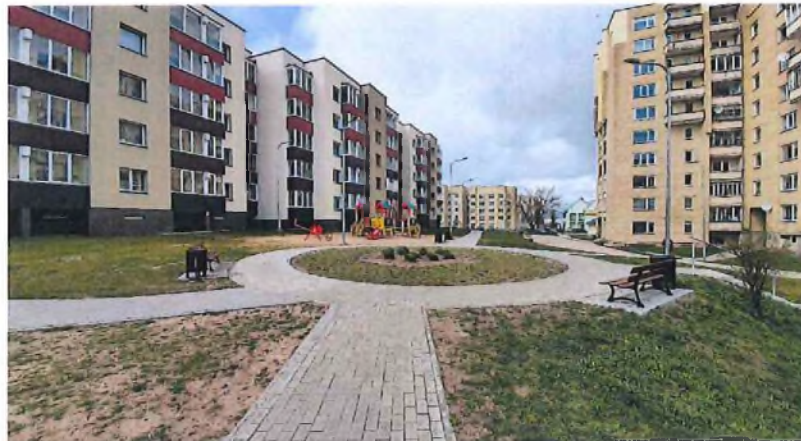
11 pav. Daugiabučių namų atnaujinimas (modernizavimas) Utenos mieste
