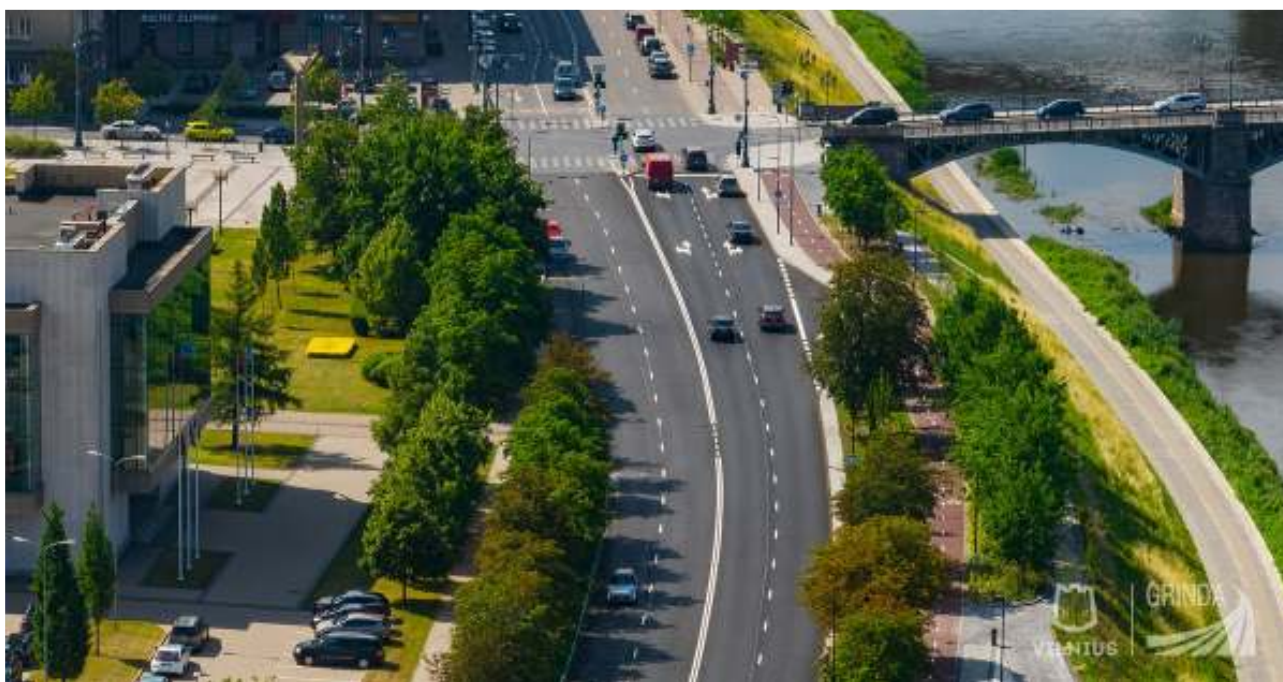
1 pav. Atlikta A. Goštauto gatvės remonto darbai
