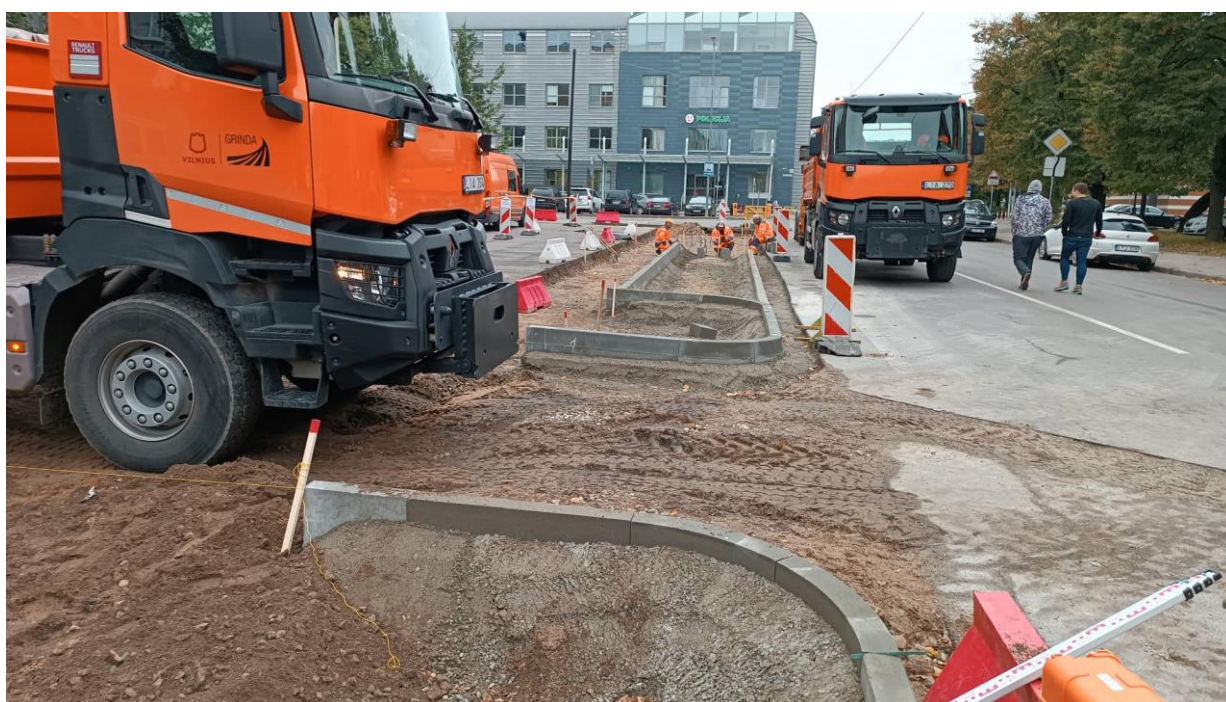
1 pav. T. Ševčenkos gatvės remonto darbai
