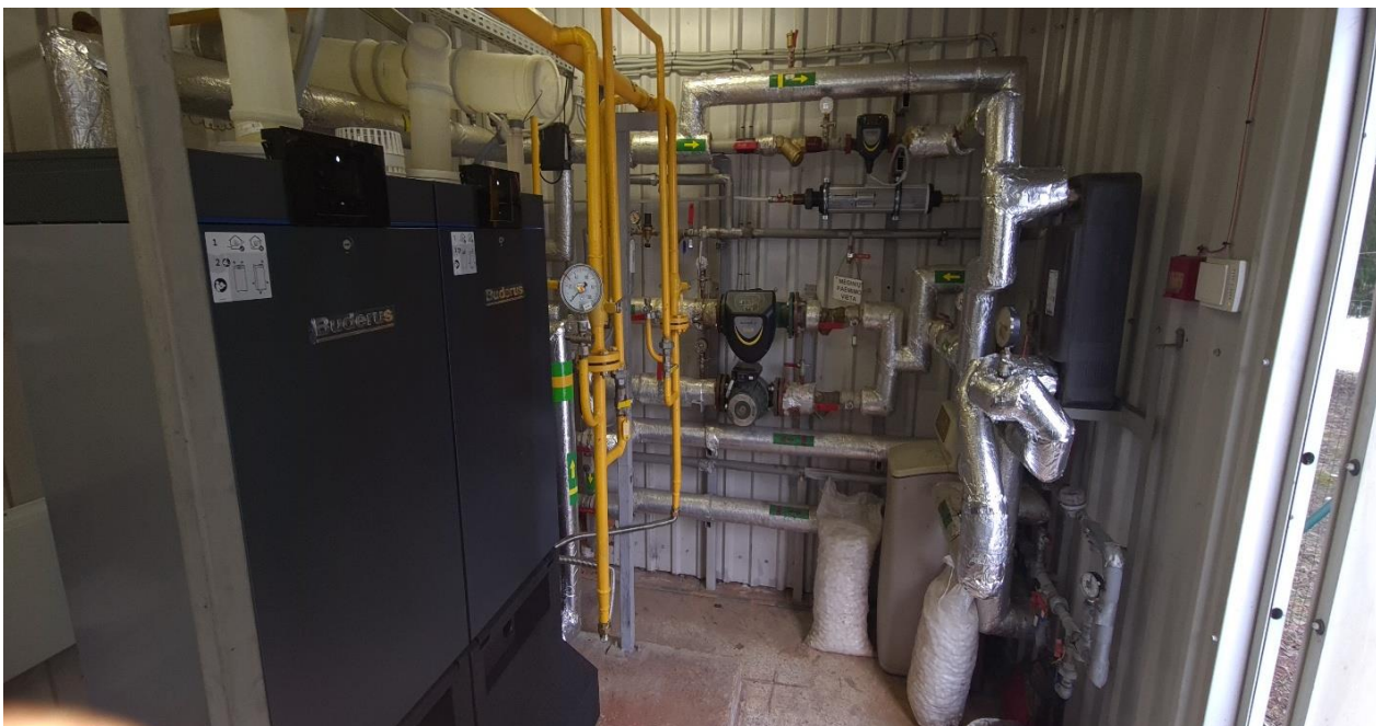
3 pav. Dujiniai katilai Logomax plus GB272-70 H – 2 vnt. Avižienių k., Gėlių g. 4 katilinė
