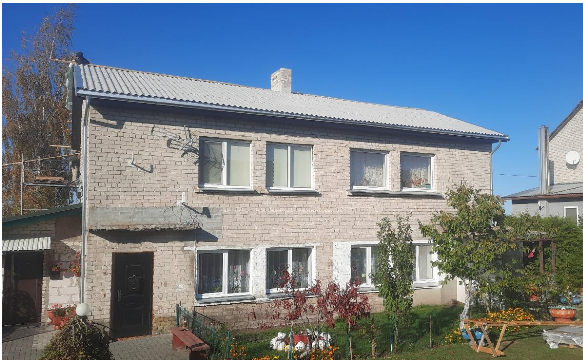
7. Didžioji g. 35, Visalaukėnė I k., Paberžėnė sen. stogo remonto darbai. VRSA dalis - 9 283,94 Eur
