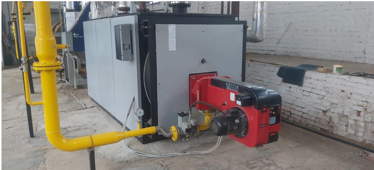
5 pav. Katilas UNICAL ELLPREX 3000 Buivydiškių k., Beržų g.3 katilinė
